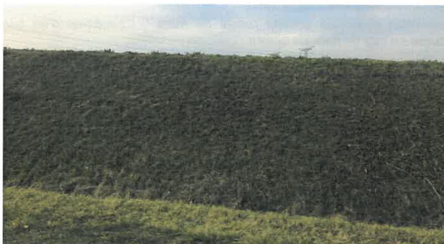
Merlon vu depuis la RD4 - Photographie sur site (15/11/2017)
